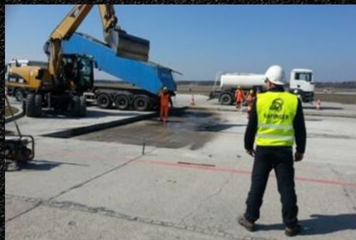
Naprawa betonowego pasa startowego na lotnisku w Modlinie
