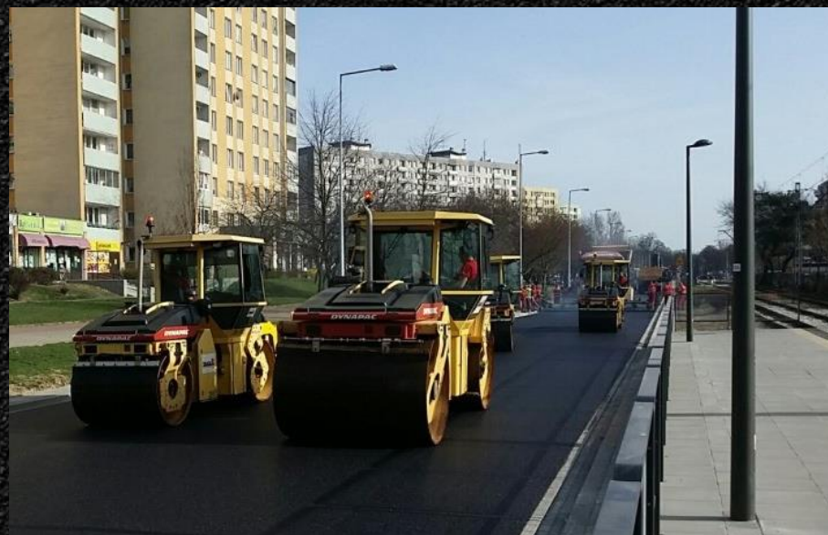
Weekendowy remont asfaltowej drogi w Warszawie
