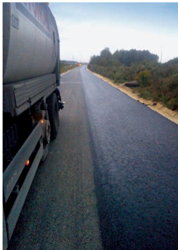
Nawierzchnia bitumiczna przed i po skropieniu emulsją
