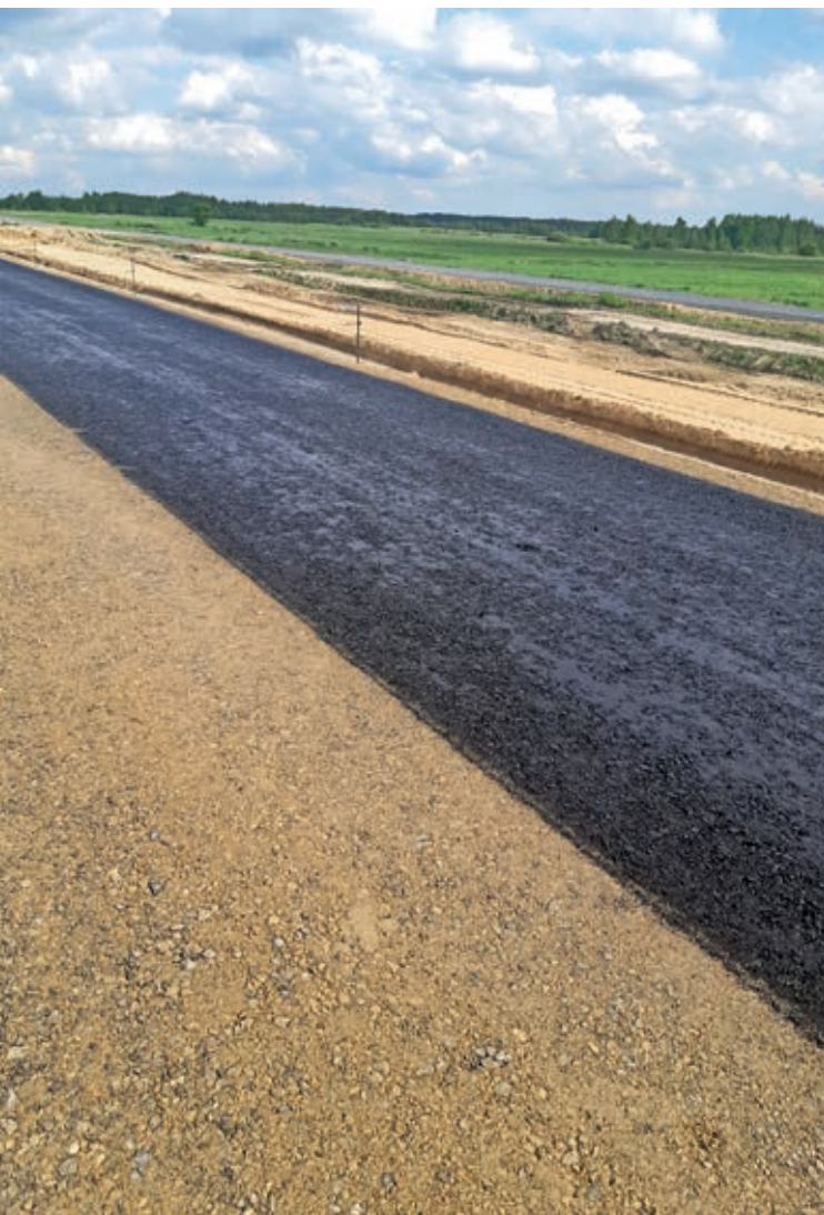
Skropiona podbudowa z kruszywa
