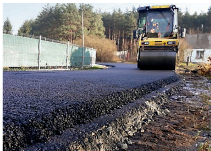
Fot. 3. Układanie SMA JENA (fot. Przemysław Zalewski)
