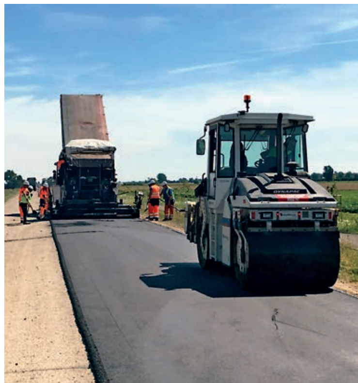
Fot. 2. Układanie warstwy AC AF (fot. Dawid Żymelka)
