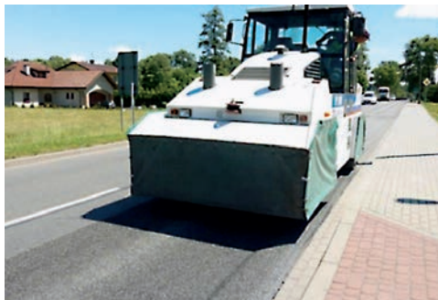
Fot. 6. Walec ogumiony dociskający PU; źródło: broszura Komisji Emulsyjnej Powierzchniowe utrwalenia, www.pswna.pl/komisja-emulsyjna/
