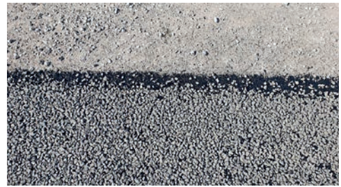
Fot. 1. Świeżo ułożone PU; źródło: zasób własny
