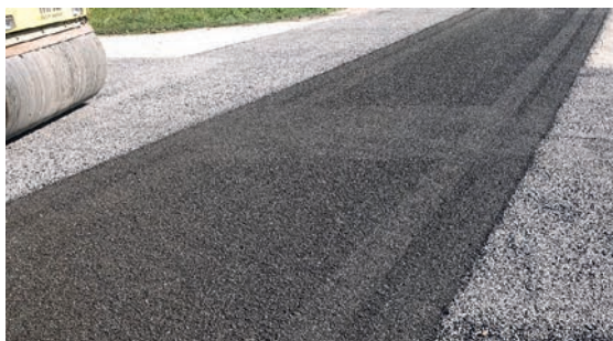
Fot. 5. Świeżo ułożone warstwy PU; źródło: zasób własny
