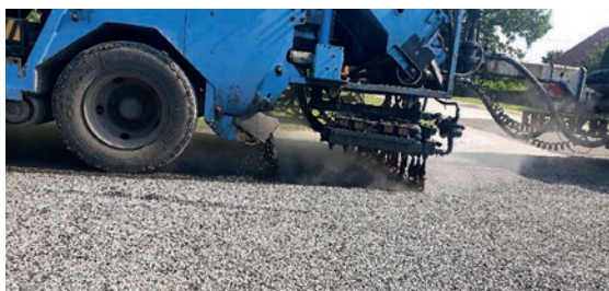
Fot. 4. Układanie PU; źródło: zasób własny
