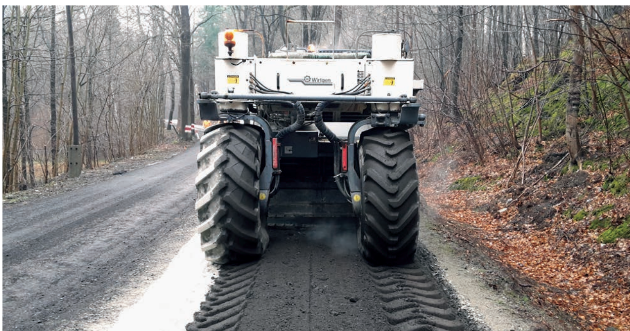
Fot. 1. Produkcja mieszanki mineralno-emulsyjnej MCE w miejscu wbudowania
