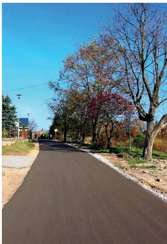
Fot. 6. Ułożona warstwa mieszanki mineralno-emulsyjnej zwanej: beton asfaltowy emulsyjny
