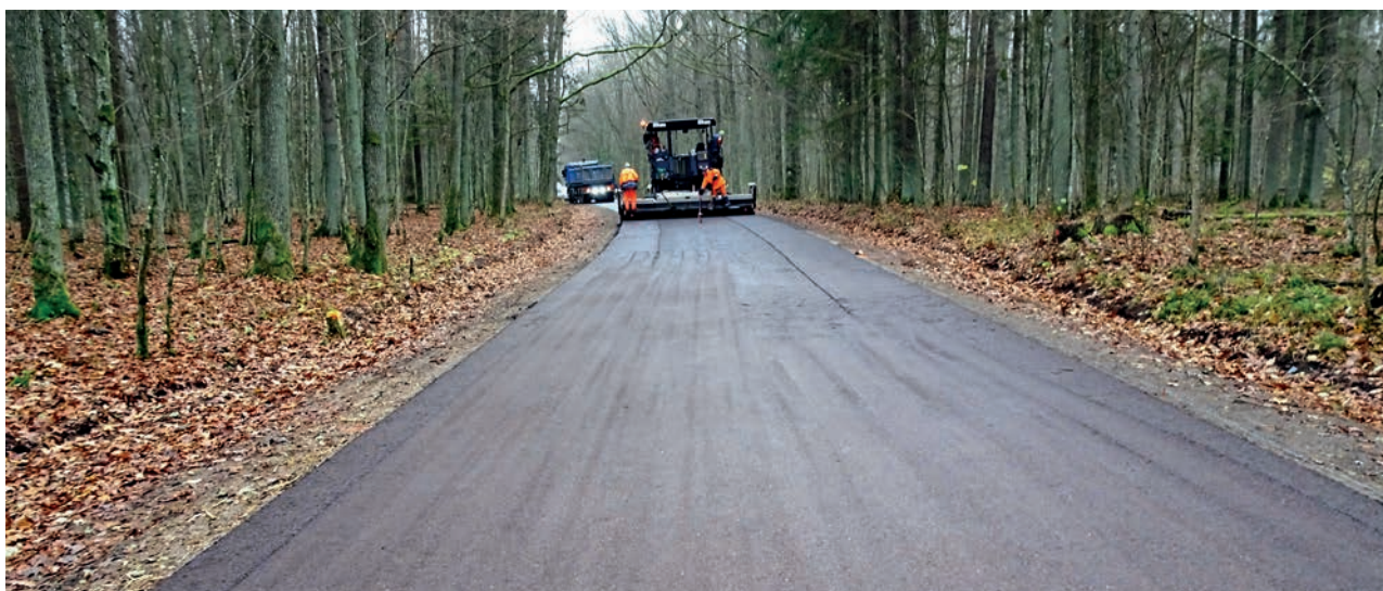
Fot. 4. Układanie mieszanki GE na drodze leśnej
