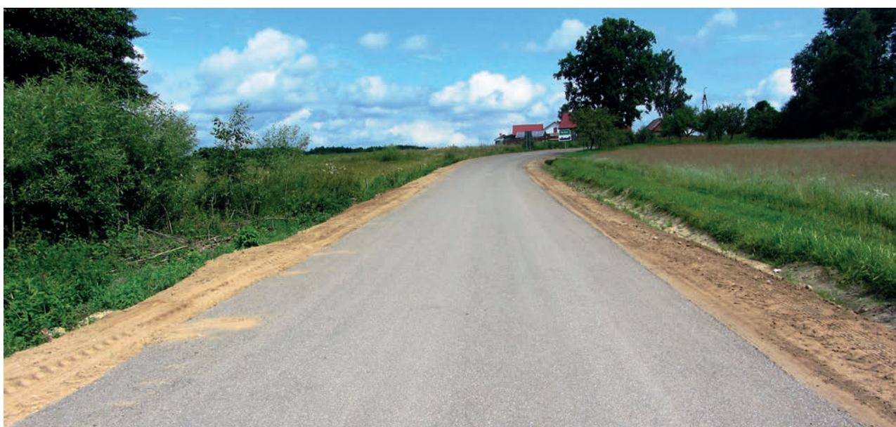
Fot. 5. Mieszanka GE przykryta utwaleniem powierzchniowym
