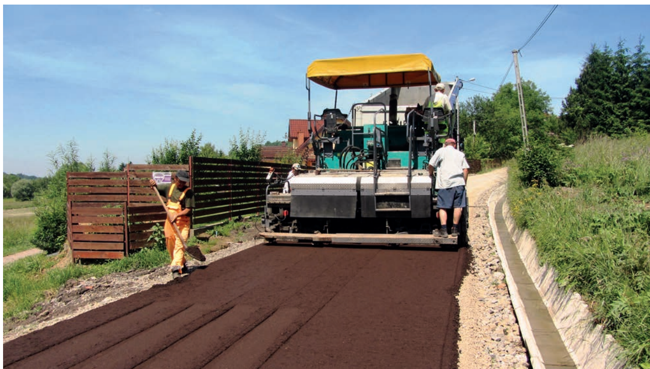
Fot. 3. Układanie mieszanki mineralno-emulcyjnej GE
