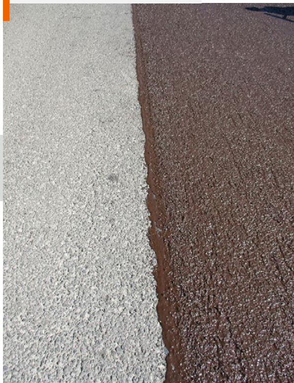
Struktura ułożonej warstwy podczas wykonywania CWZ
