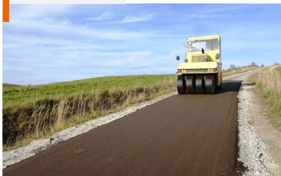
Zagęszczanie mieszanki GE
