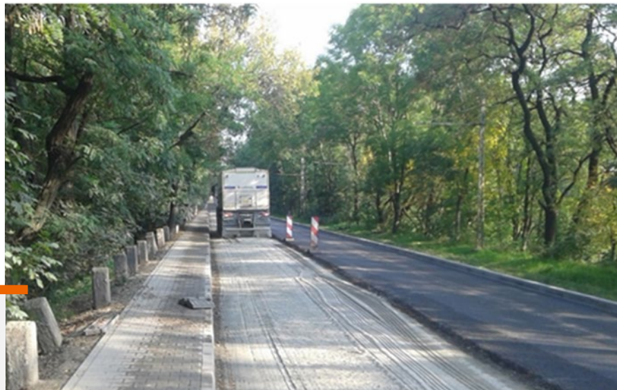
Proces rozsypywania cementu – wykonanie MCE „in situ”
