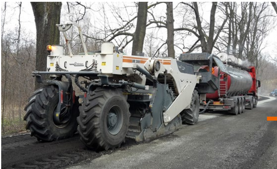
Recyker Wirtgen w zestawie z cysterną transportującą emulsję asfaltową
