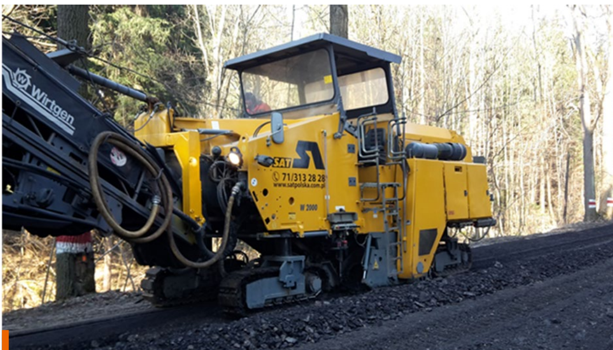
Proces frezowania nawierzchni asfaltowej w celu pozyskania destruktu do mieszanki MCE
