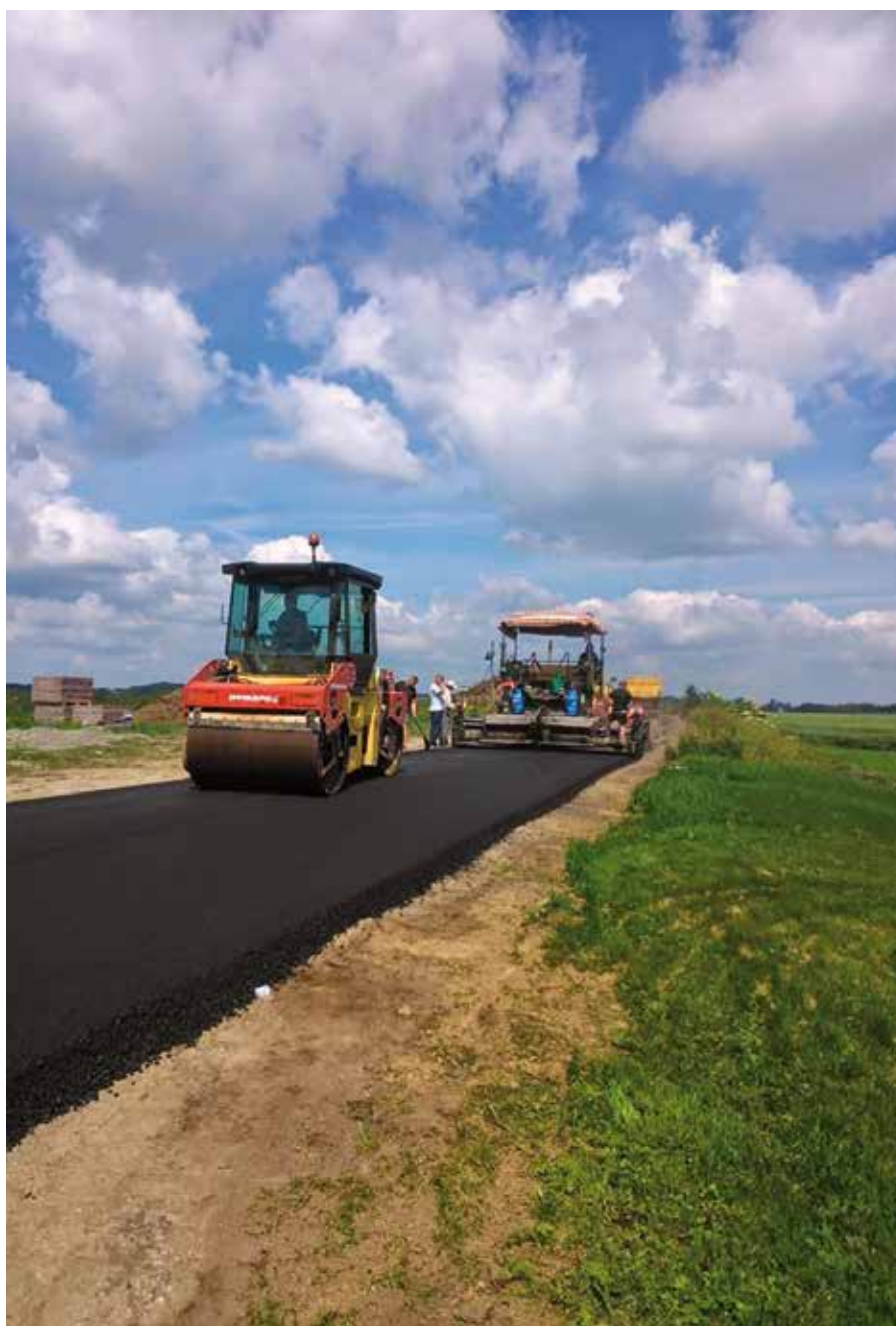
Realizacja firmy PPUH TUGA, droga nr 2903 w gminie Mątowy Małe
