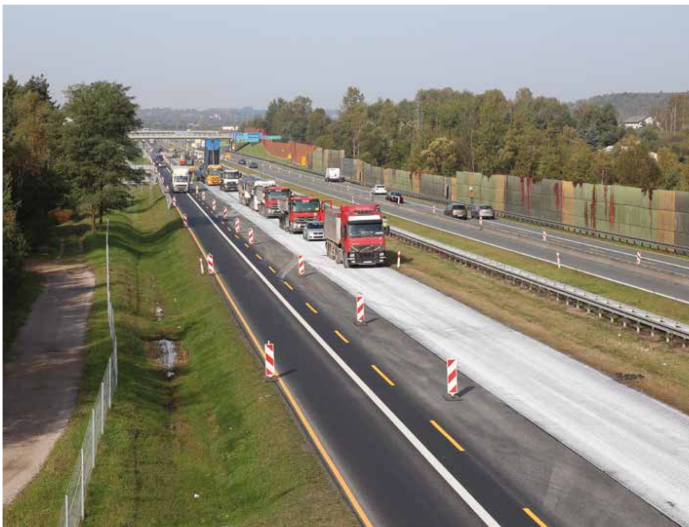
Zabezpieczenie warstwy szpempnej podczas wymiany warstwy ścieralnej na autostradzie A4 Kraków–Katowice
