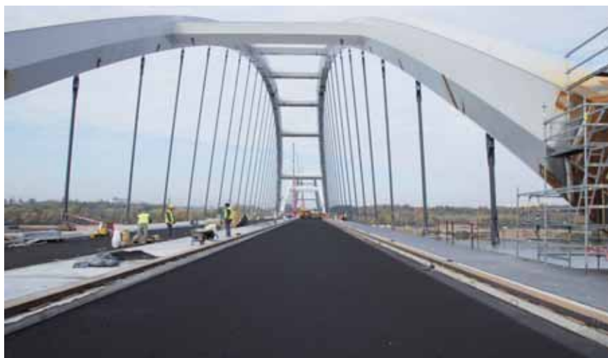
Fot. 3. Widok na wyprofilowane torowisko do jazdy rozkładarki wykonane ze stalowych profili, ustawione na kapach chodnikowych w celu osiągnięcia maksymalnej możliwej równości nawierzchni z asfaltu lanego
