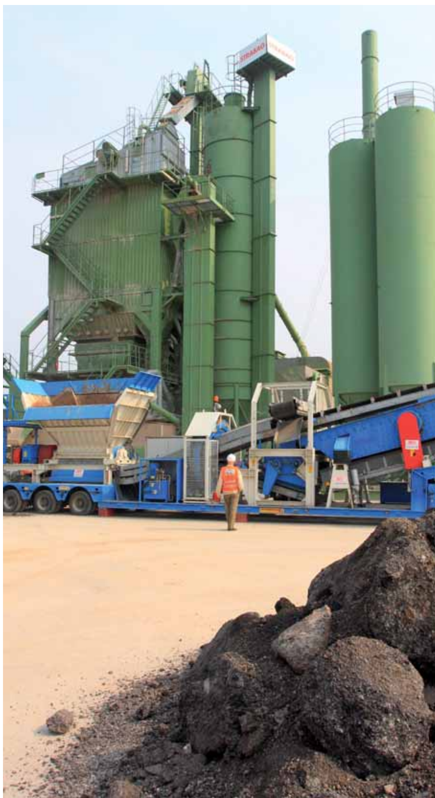
WMB będąca własnością firmy STRABAG i Granulator. Na pierwszym planie destruk, który za chwilę zostanie przekształcony w granulację
