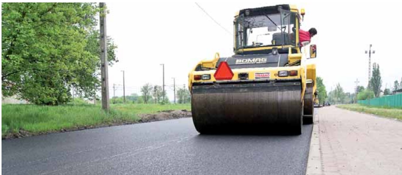
Wbudowywanie AC 16 DT
