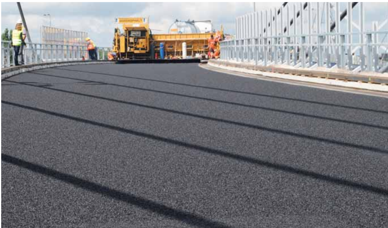
Układanie warstwy ścieralnej z asfaltu lanego w Toruniu
