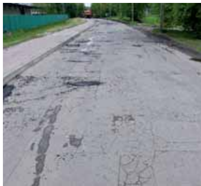
Fot. 1. Nawierzchnia drogi przed skropieniem i ułożeniem warstwy w technologii nawierzchni jednowarstwowej
