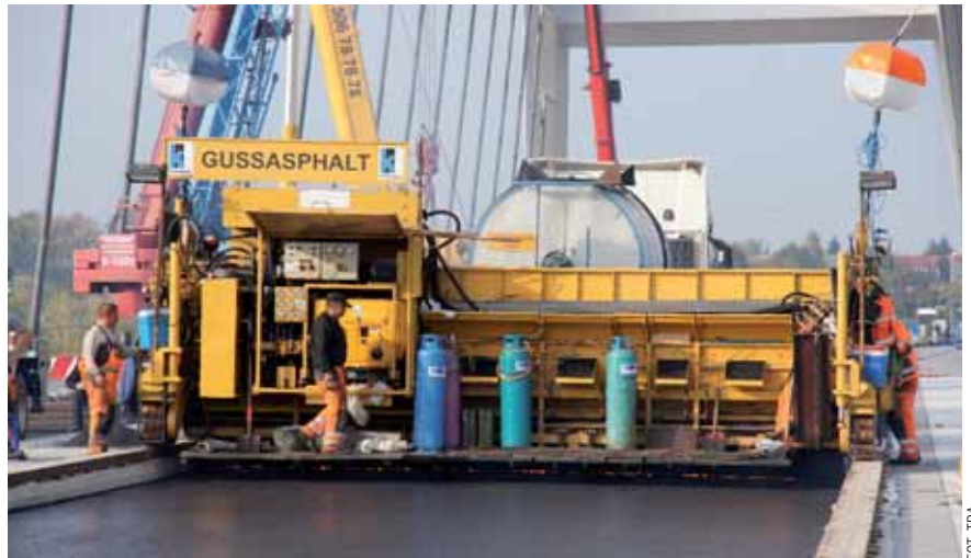
Fot. 4. Rozkładarka ze zintegrowaną posypywarką grysu do układania asfaltu laneo na całej szerokości jezdni bezszwowo z możliwością wykonania przeciwspadku
