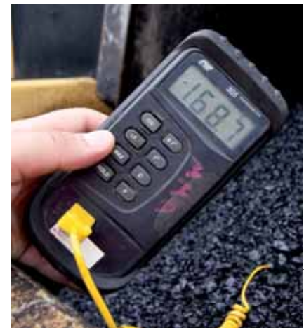
Fot. 3. Pomiar temperatury mma w czasie wbudowywania
