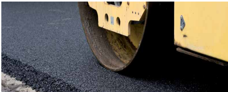
Fot. 4. Jednowarstwowa mieszanka AC 16 TD o grubości 6–7 cm w trakcie zagęszczania
