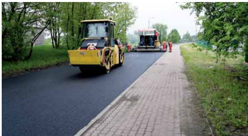
Fot. 2. Wbudowywanie i zagęszczenie warstwy
