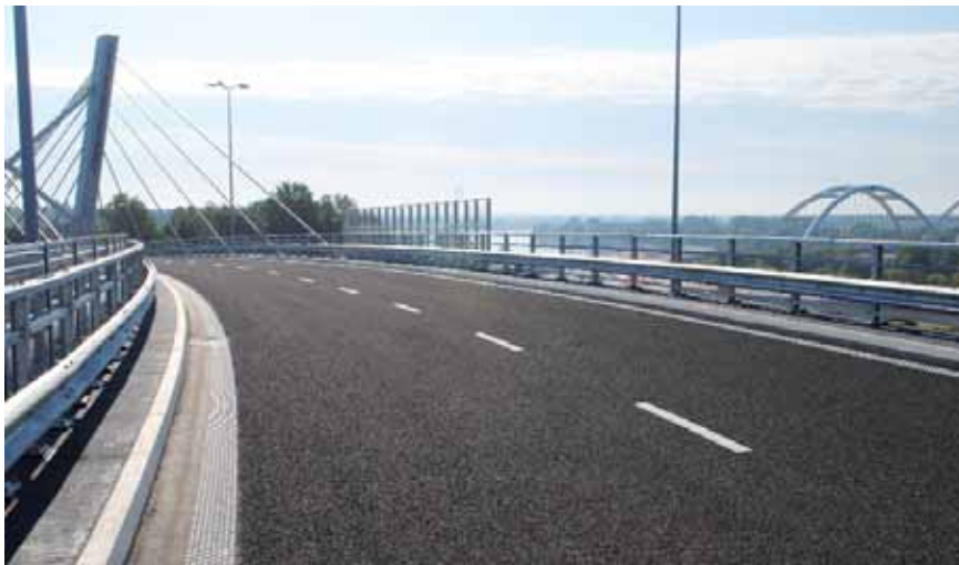
Fot. 5. Widok na gotową warstwę ścierną asfaltu laneo z grysem lakierowanym na Estakadzie Żółkiewskiego, w tle nowy most przez Wisłę
